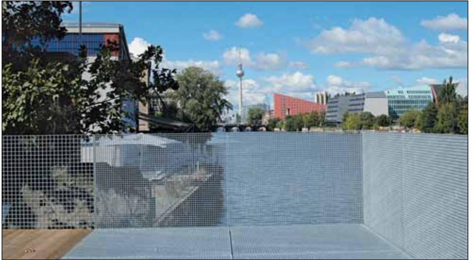
8 Boden und Geländer aus Pressrosten: Brommybalkon in Berlin
