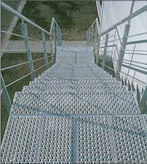
7 Treppe mit Stufen aus Blechprofilrosten
